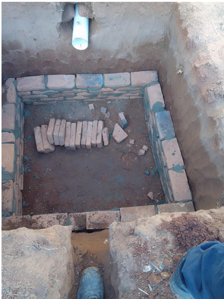
REPARACION DE POZO CIEGO EN LA ESC. BAS. N° 239 CARMEN B. DE GOROSTIAGA
