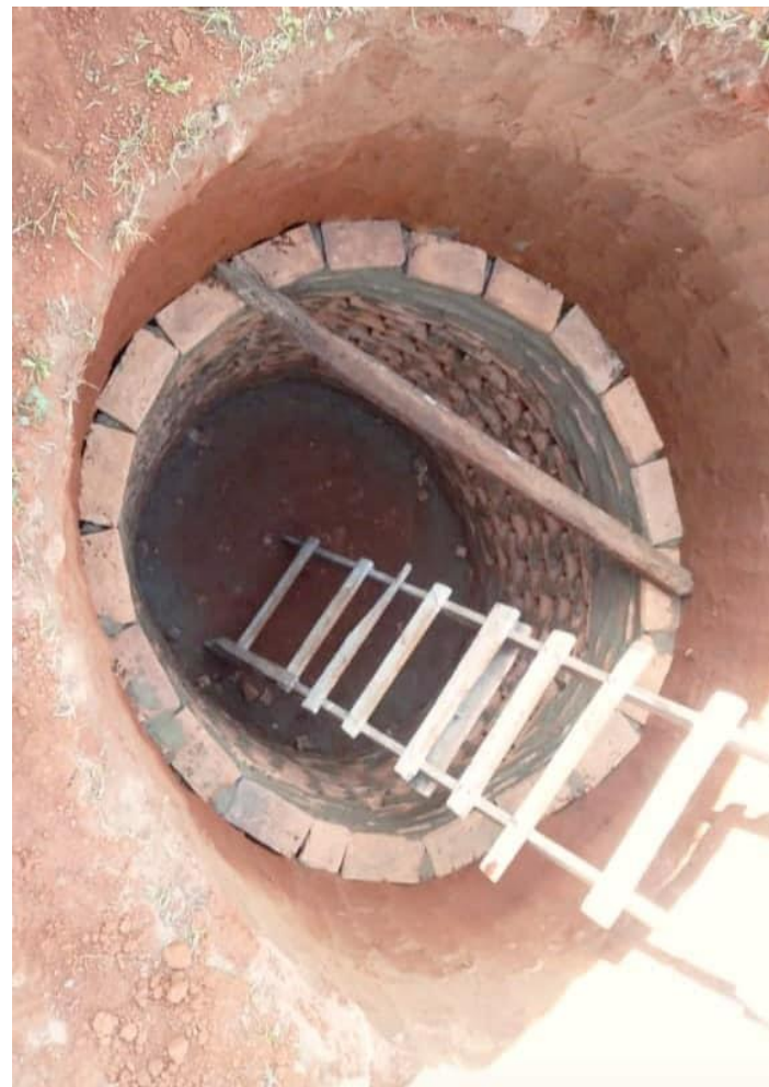
REPARACION DE POZO CIEGO EN LA ESC. BAS. N° 239 CARMEN B. DE GOROSTIAGA
